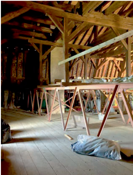
Das Dachgeschoss heute
