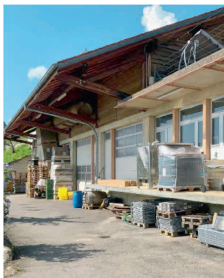
Façade Sud actuelle
