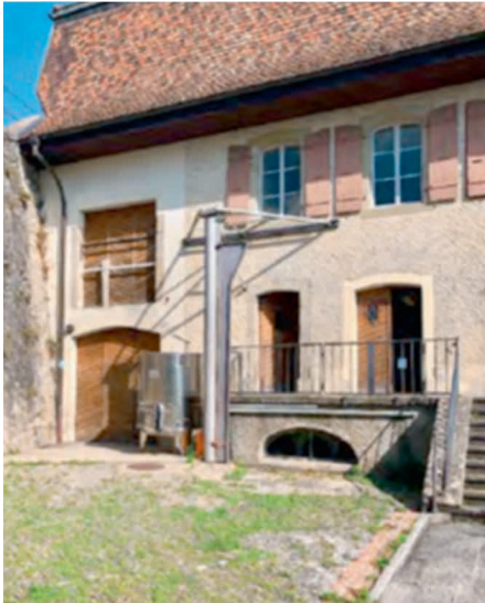
Façade Ouest actuelle
